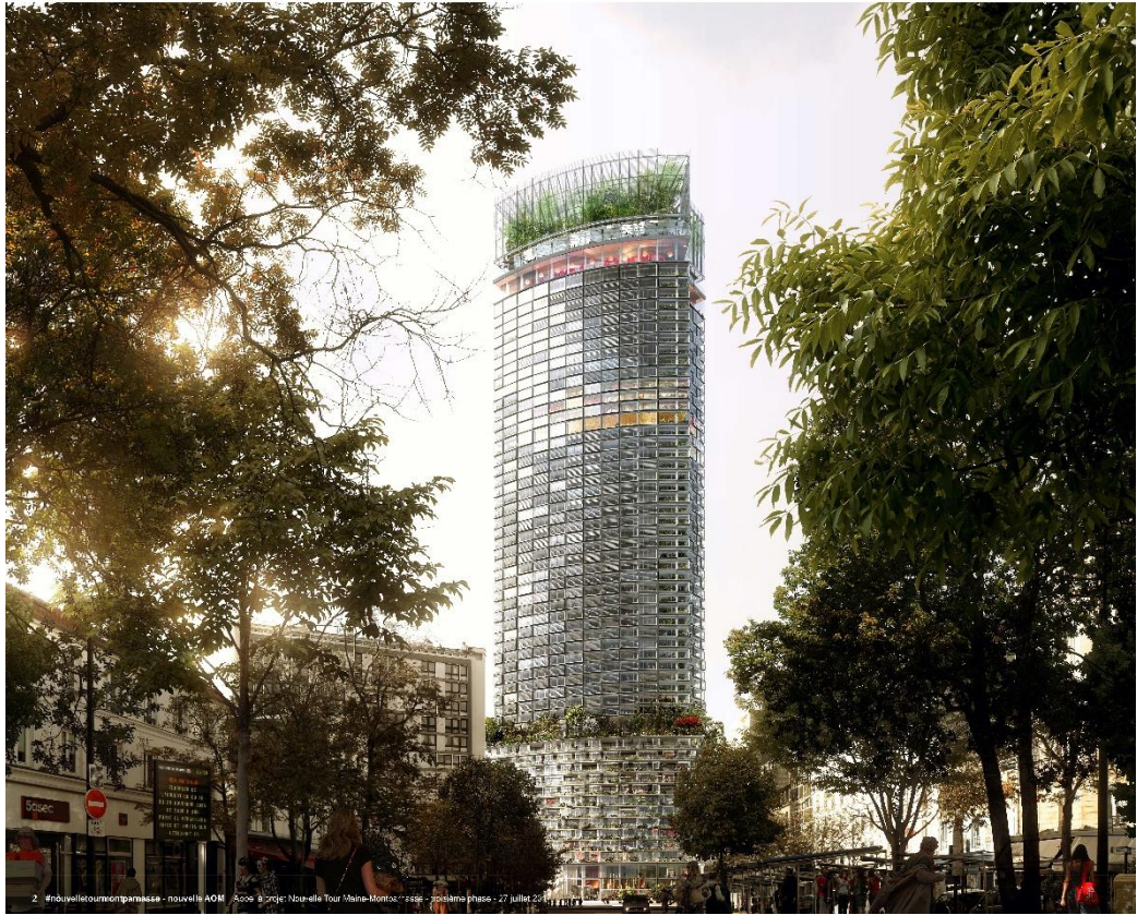
2 #nouvelletourmontparnasse - nouvelle AOM AOM à Paris: Nouvelle Tour Montparnasse - troisième phase - 27 juillet 2011
